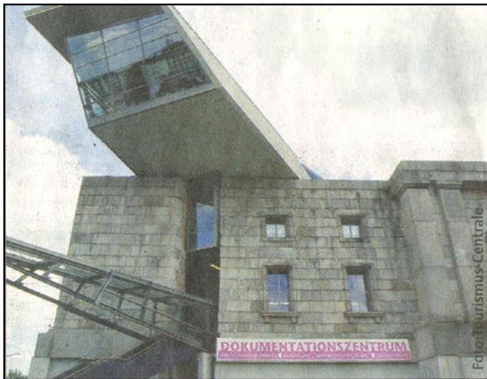
Ein neues umfassendes Info-System wurde im Doku-Zentrum installiert.
