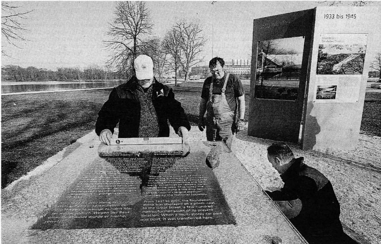
Die Handwerker Iwan Gebert, Norbert Wilsch und Horst Wießner (von links) bringen den Grundstein ins Lot. Foto: Hippel
